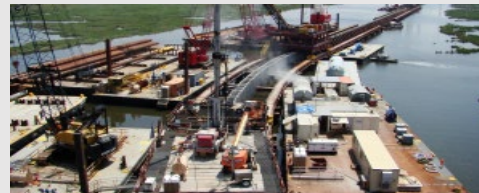
IHNC Flood Barrier
